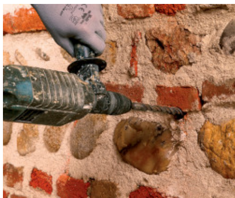
Furatok előkészítése a MapeWall EM Connector számára
