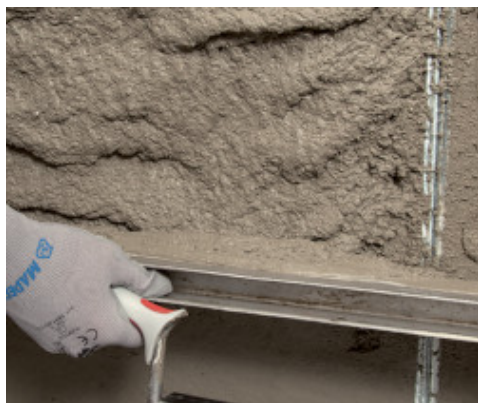
A MapeWall Inject & Consolidate simítása egyenes simítóval
