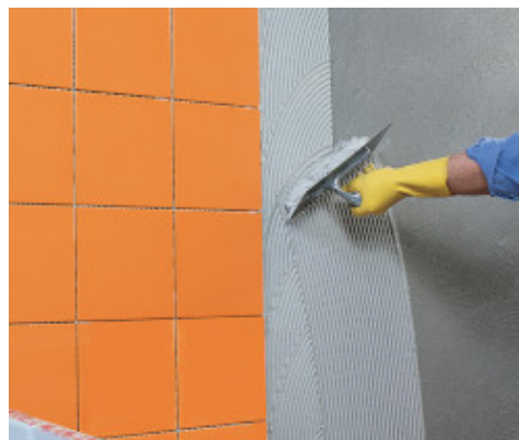
A MapeWall Intonaca & Rinforza második rétegének bedolgozása
