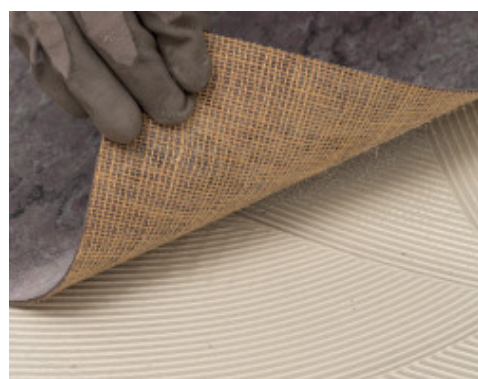
Linóleum fektetése Ultrabond Eco V4 Evolution-nel
