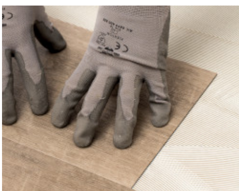
LVT fektetése Ultrabond Eco V4 Evolution-nel
