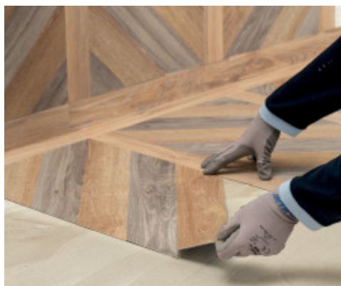
Modul LVT fektetése Ultrabond Eco V4 Evolution-nel
