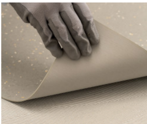
Gumiburkolat fektetése Ultrabond Eco V4 Evolution-nel
