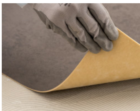
Poliuretán bázisú padlóburkolat fektetése Ultrabond Eco V4 Evolution-nel
