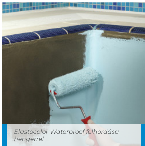
Példa Mapeelastic Smart-tal vízszigetelt Elastocolor Waterproof-fal bevont ereszcsontra
