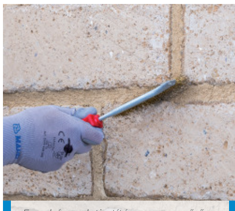
Fugahézagok tisztítása merev szőrű ecsettel
