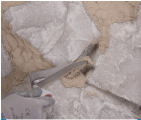
Kőfalazat hézagainak pontszerű javítása
