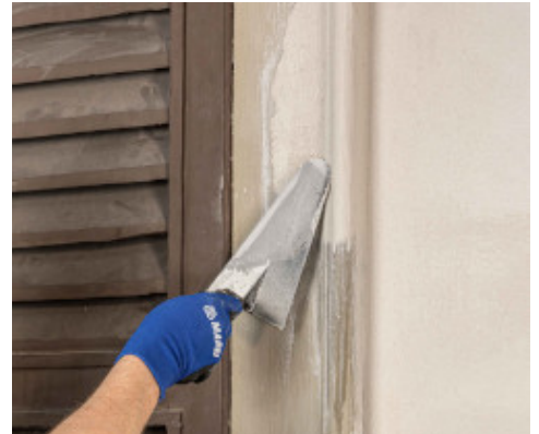
Építési elemek helyreállítása
