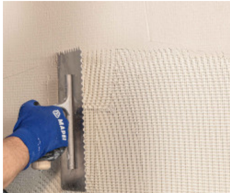
Üvegszövet háló beillesztése az első simítórétegbe
