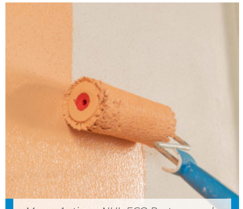
Mape-Antique NHL ECO Restaura-val helyreállított felület festése
