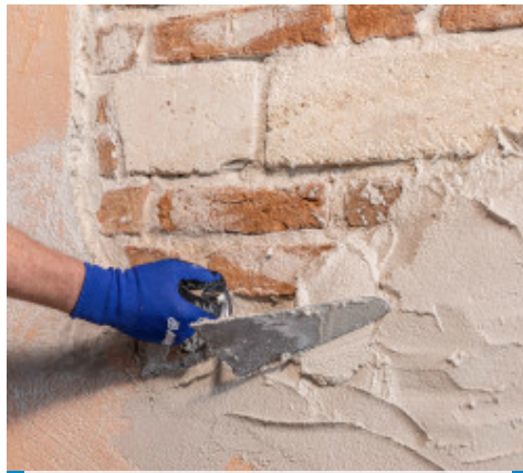
Vakolat kiegyenlítése és javítása
