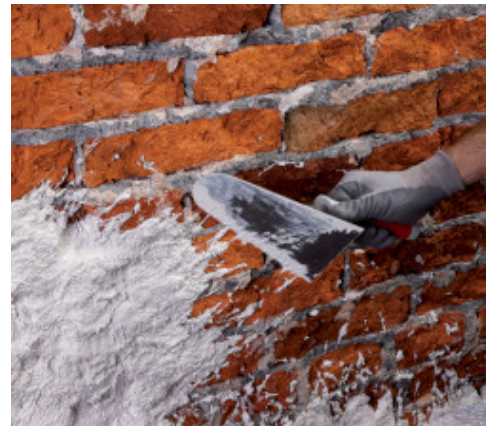
A Mape-Antique Rinzafo felhordása
