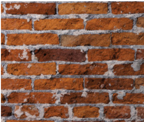
Téglafal a károsodott vakolat eltávolítása után
