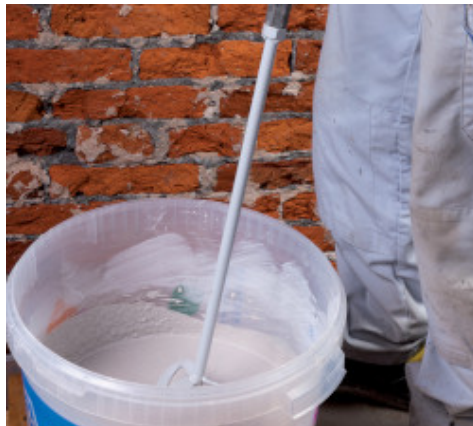
A Mape-Antique Rinzafo elkészítése
