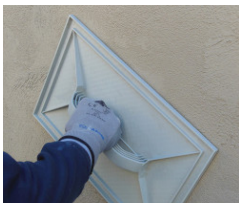
A MapeWall Intonaco Base felületének besimítása
