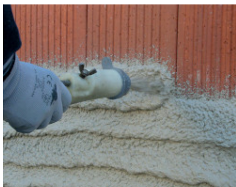
A MapeWall Intonaco Base felhordása vakológéppel új vázkerámia falra
