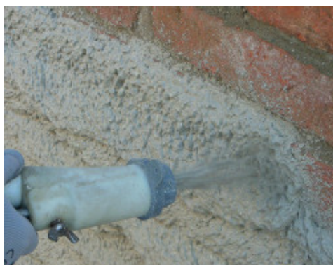
A MapeWall Intonaco Base felhordása vakológéppel tömör téglafalra
