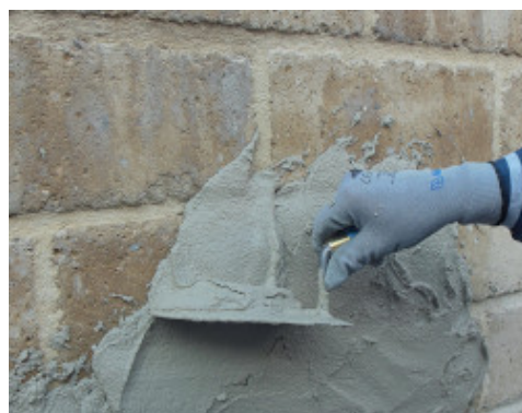
A MapeWall Intonaco Base felhordása kőműveskanállal tufa falra
