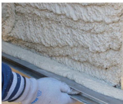
A MapeWall Intonaco Base felületének lehúzása lapos simítóval
